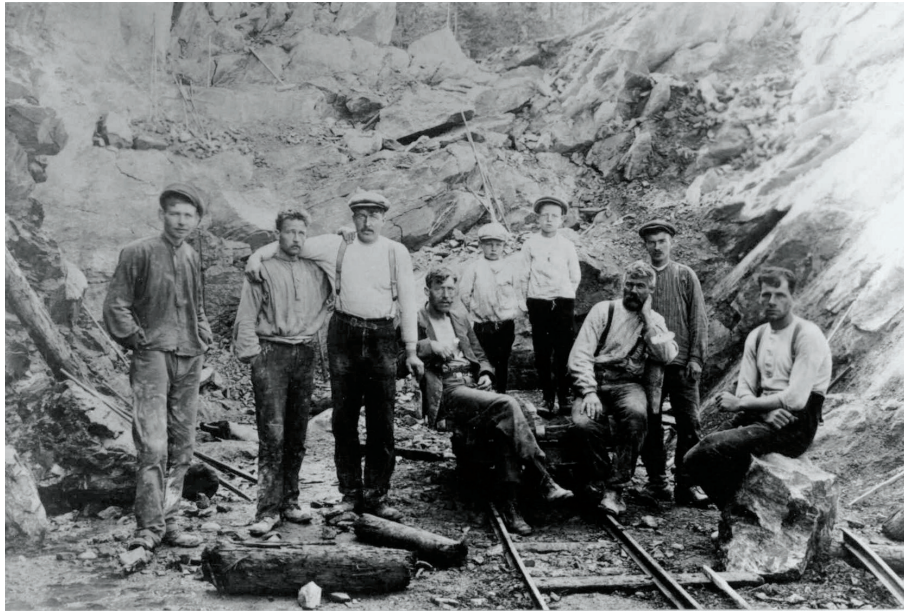
Jernbanearbeidere på Dovrebanen ved Rennebu, 1911-1913.
